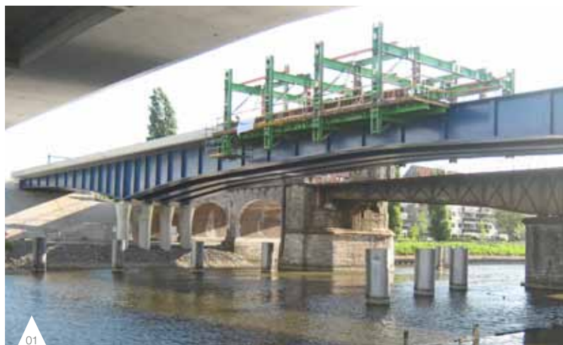
01 Waggelwater bridge, Brugge, Belgium
